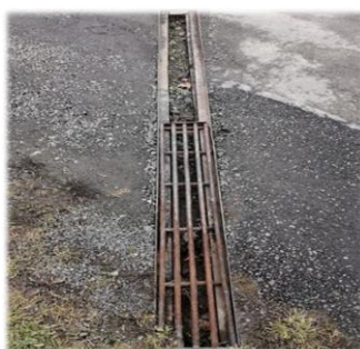
Drenážní kanál na silnici k retenčním rybníkům. Aktuálně se vyrábí, instalace do konce června
