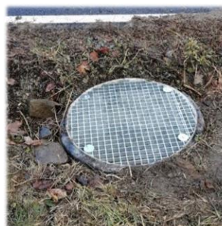
Nový kanál na řádu dešťové kanalizace
