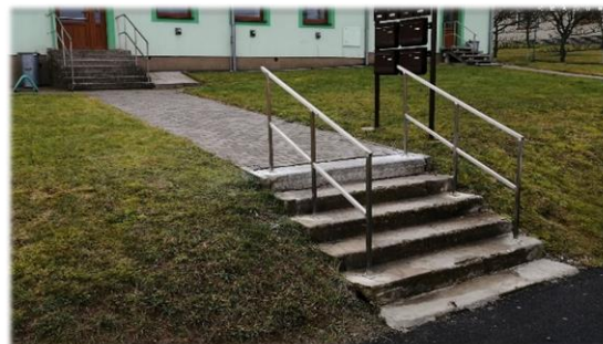
Zábradlí před OÚ a bytem řidičů.
