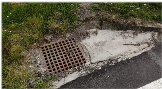
Čistění a oprava kanálových vpustí.
