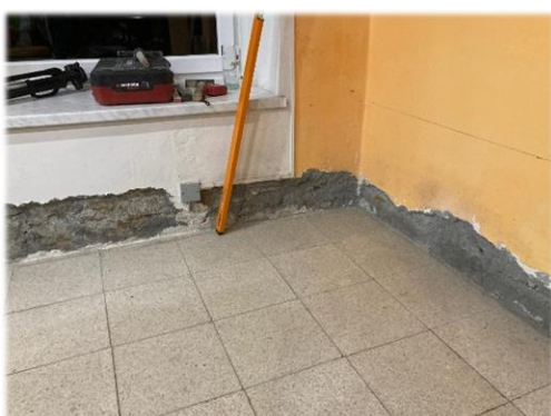
Výmalba a oprava (odvětrávání) obvodových stěn v obecním obchodě
