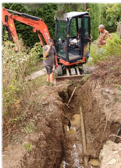
Oprava poruchy na vodovodním řádu (tímto se omlouváme za zhoršení kvality a dostupnosti pitné vody v období 16-18. srpna)
