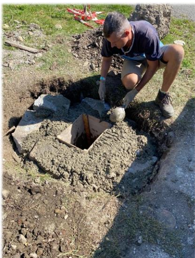
Kompletní renovace zborcené šachty dešťové kanalizace
